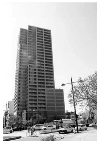
建設中の両備グレースマンション(野田屋1丁目・柳川交差点)
